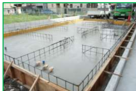
基礎ベースコンクリートの打設
