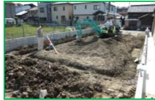
基礎工事スタート
