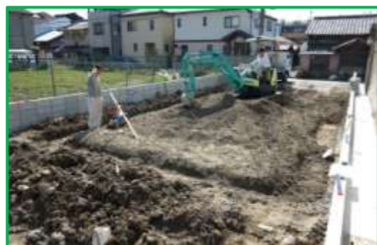
基礎工事スタート
