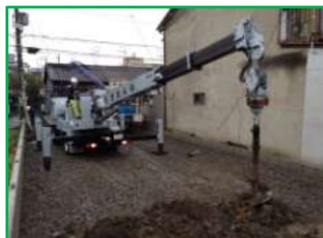
地盤改良工事
