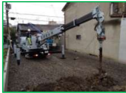
地盤改良工事
