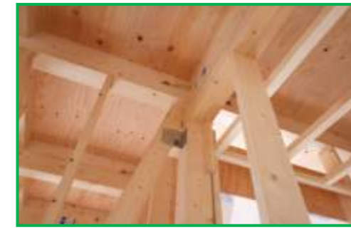
公的機関・住宅あんしん保証における 中間検査を実施
