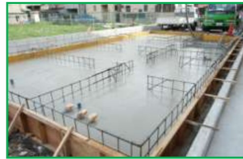
基礎ベースコンクリートの打設
